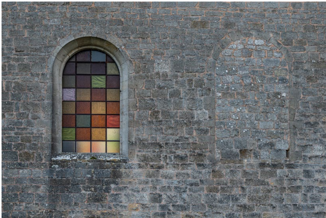
Des vitraux de la chapelle du fort Saint-André ont été murés lors de la reconversion du lieu en grenier à grain.
